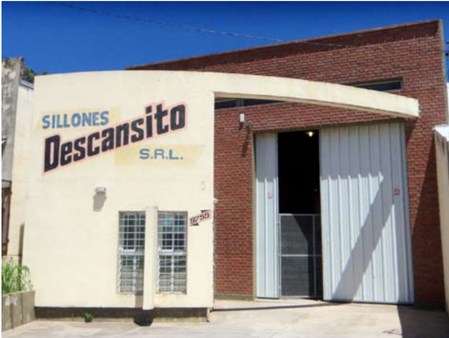
La fábrica de El Descansito.
