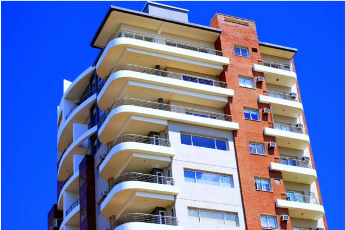
Nuestras aberturas en un edificio en la Costanera de Posadas.
