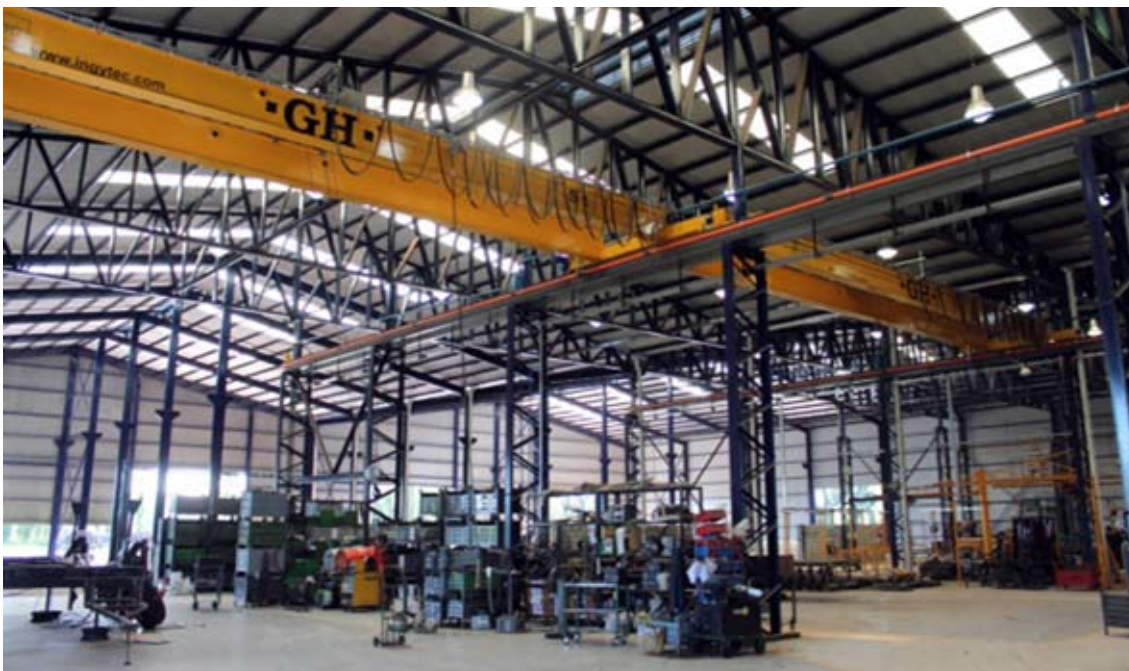
Interior de la nueva planta de ERCA.
