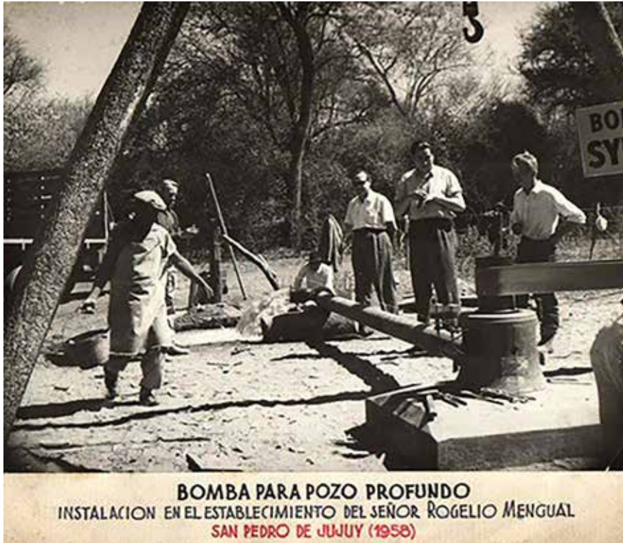
Instalación de bomba para pozo profundo. 1958.
