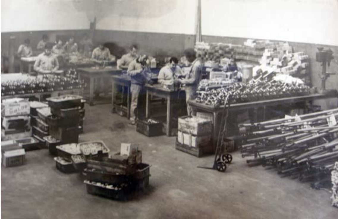
La planta, en sus comienzos. Fines de los '60.
