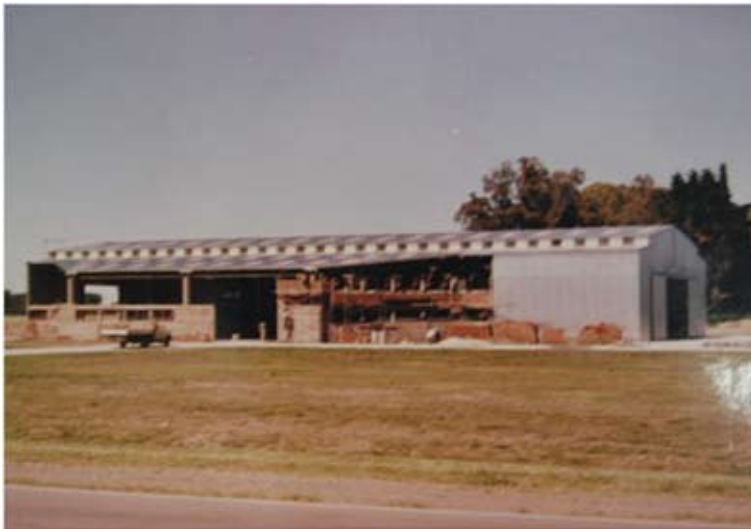
La construcción de la planta de Yomel. Década del '80.
