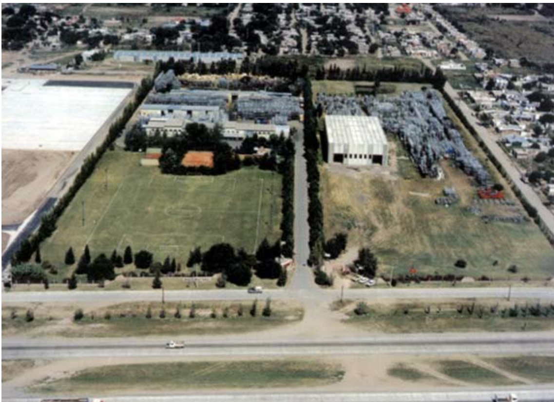
La planta de Fumiscor.
