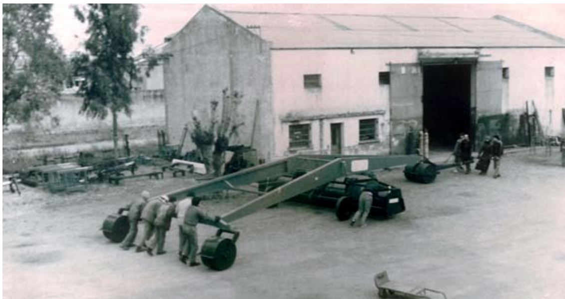
Niveladora de 26 x 8 m frente al primer galpón de Nievas. 1980.
