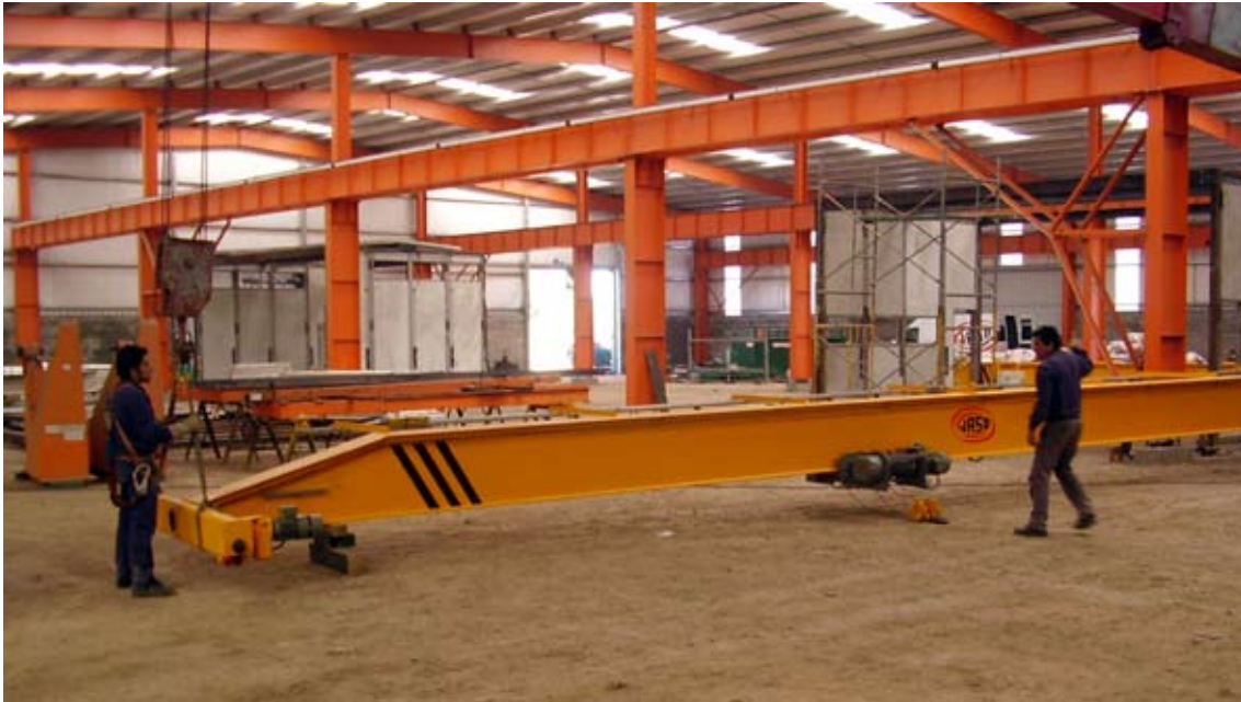
Obras de ampliación de nuestra nave industrial en 2500 m 2 equipados con la última tecnología. 2014.
