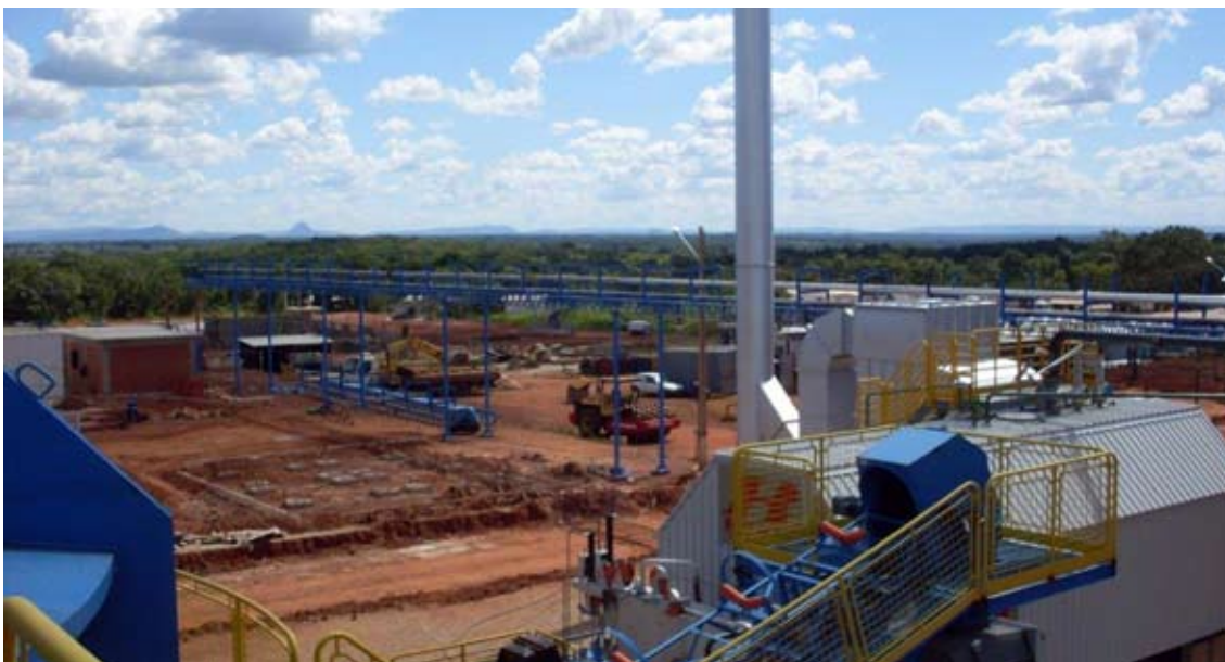
Obra de ingeniería y construcción de una planta de gelatina en Mato Grosso, Brasil.
