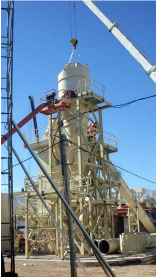
Obra de sistema de aspiraciones en una planta de Mendoza.
