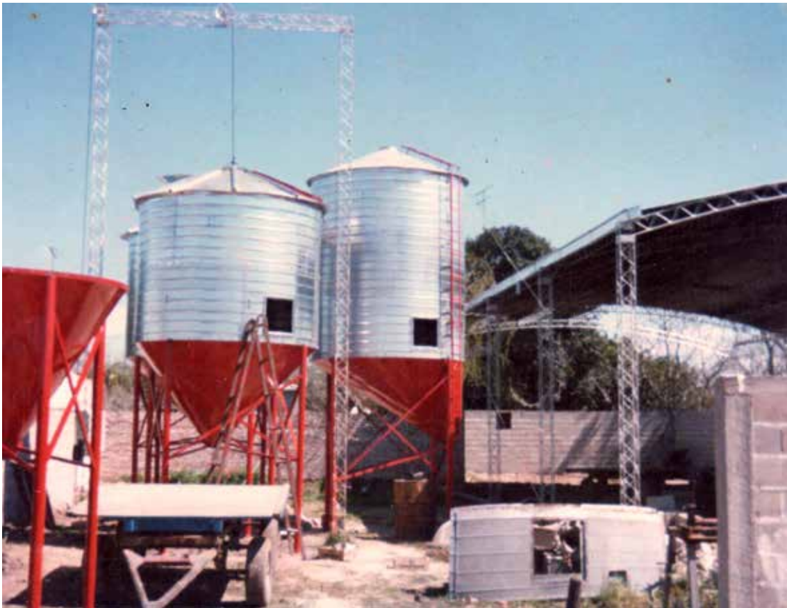
Construcción de la primera fábrica. Década del '80.
