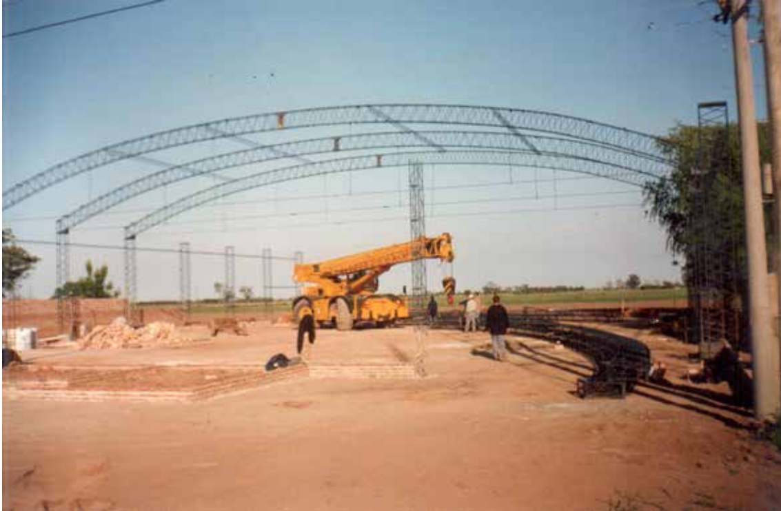
Construcción de la nueva fábrica. 1995.
