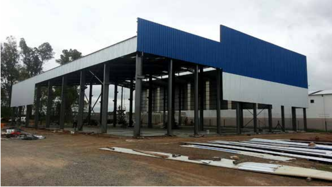
Obra de construcción de la nueva planta.
