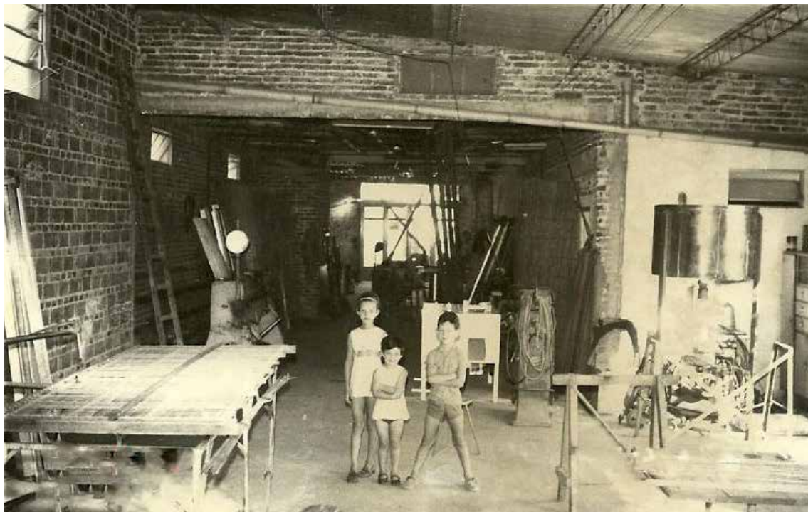
Vista del interior de la planta. 1975.
