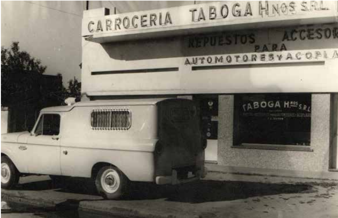
En el frente de la empresa en la calle Facundo Zuviría, camión blindado fabricado sobre una pickup Ford para el Banco Provincia de Santa Fe. Año 1969.
