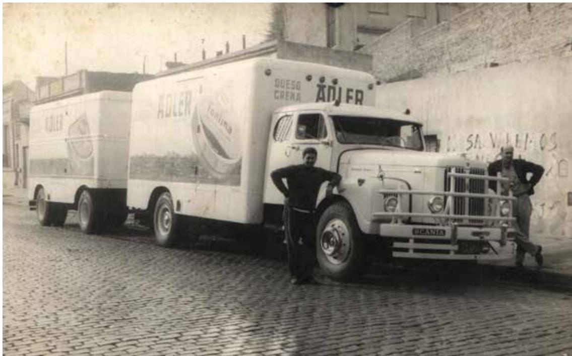
Equipo de camión y acoplado con furgón térmico para la fábrica "La Bavaria" de quesos Adler, Año 1971.
