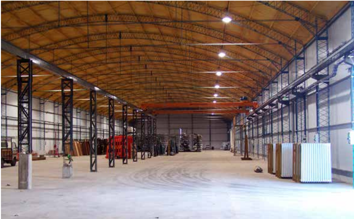
La nueva planta industrial se hace realidad. Año 2016.
