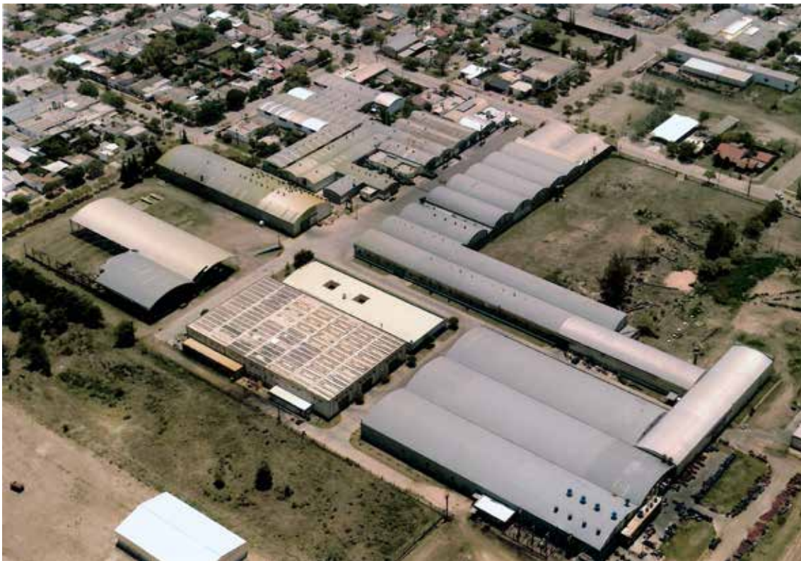
Vista aérea de nuestra planta de Las Varillas, Córdoba..
