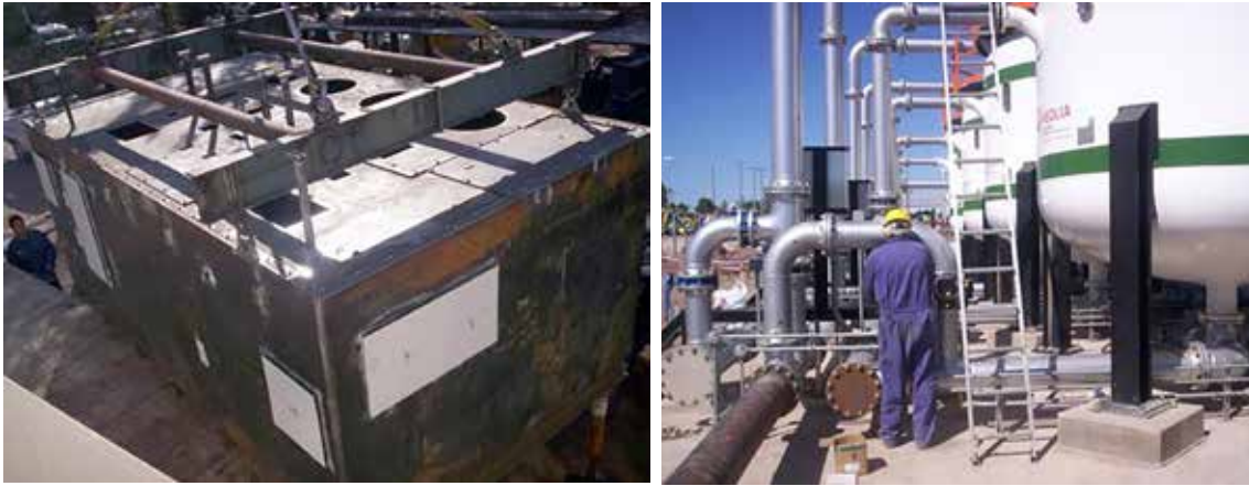
Estructuras (izquierda) y montajes industriales (derecha).
