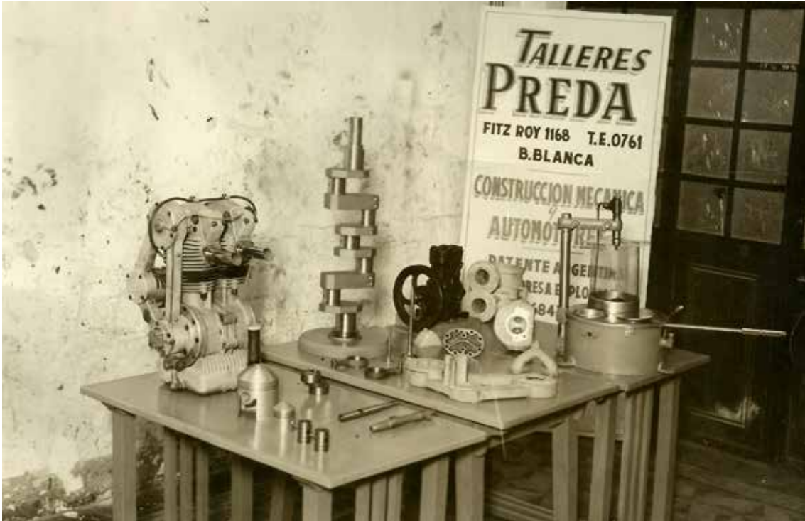
Trabajos realizados en el primer taller de la calle Fitz Roy.
