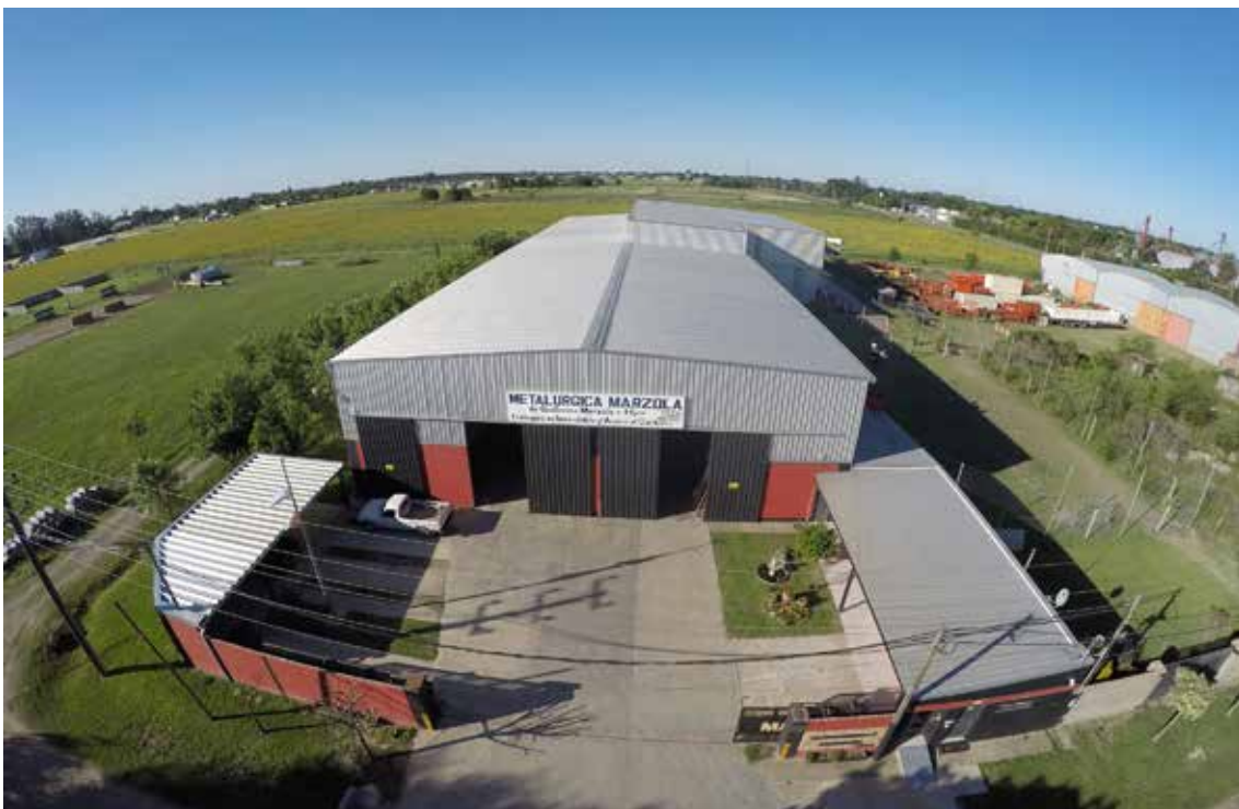
Actual planta de 2.500 m 2 .
