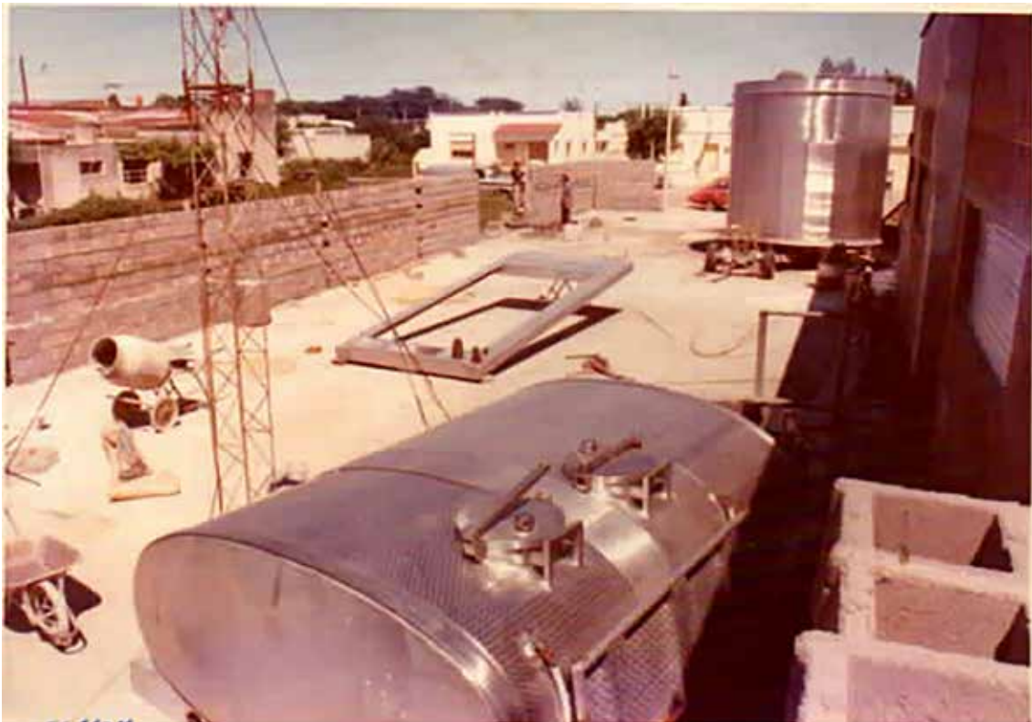
Construcción de nuestra fábrica en Sarmiento 1060 de San Jerónimo Norte.
