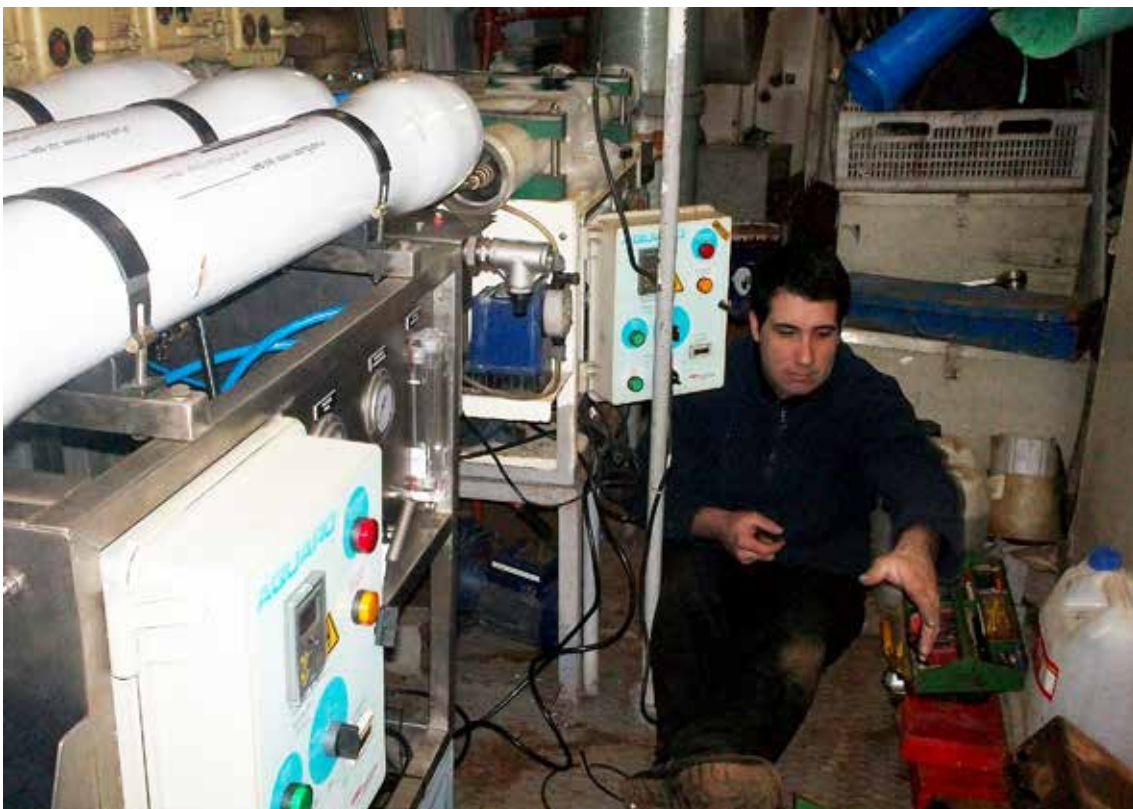
Instalando equipo desalinizador en barco pesquero.
