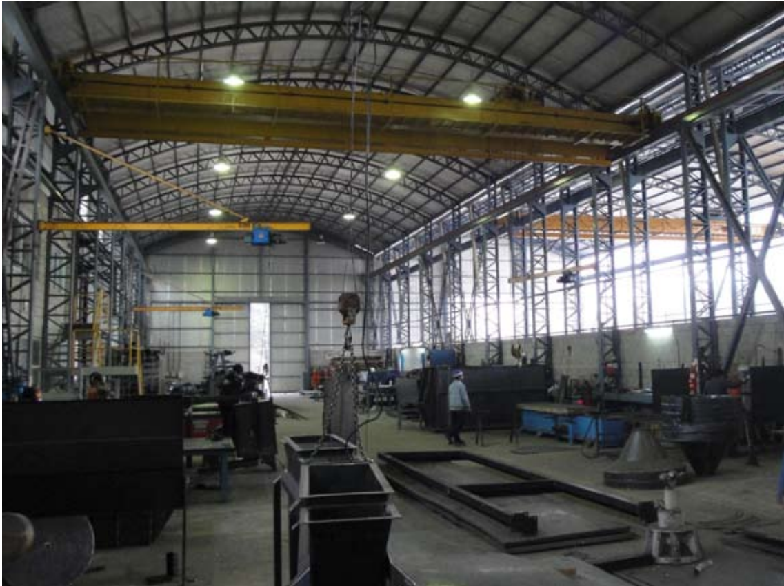
Interior de la fábrica luego de la última ampliación. Sector de dos naves de 15 m x 60 m con puentes grúa de 10 tn. 2011.
