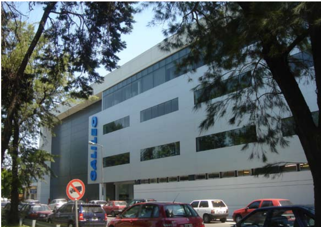
Vista del exterior de la planta de GNC Galileo S.A.
